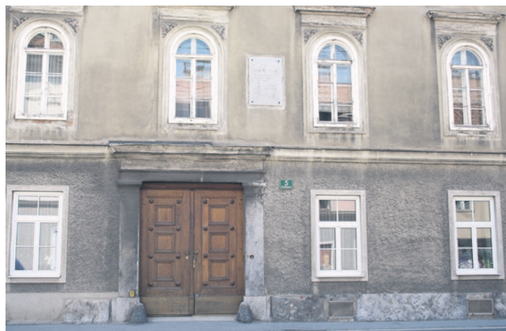
In der Wickenburggasse erinnert eine Gedenktafel an die erste Wohnung von Peter Rosegger in Graz. Diese Tafel ist in einem sehr schlechten Zustand. Sie sollte erneuert werden.
