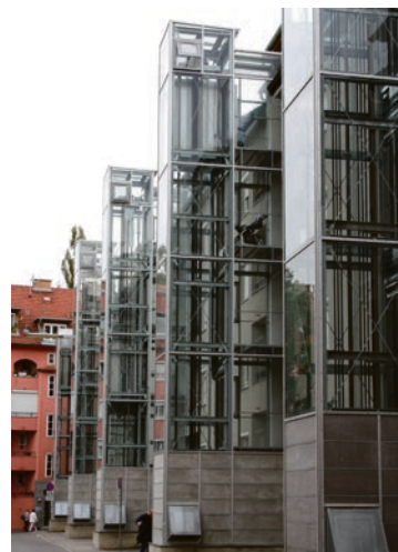
Bei einigen Wohnhäusern wurden Lifte errichtet.
