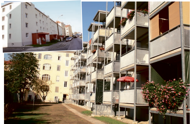
Die Häuser Schönaugasse 116 und 118 wurden in Niedrigenergiebauweise saniert. Das bringt auch niedrigere Heizkosten für die Bewohner.
