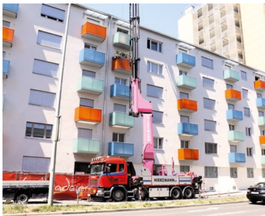
Elke Kahr veranlasste die umfassende Sanierung des Gemeindewohnhauses.
