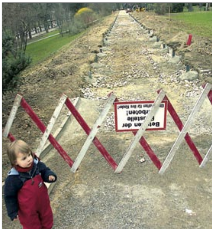
Baustelle Stadtpark: Bis 2008 mehr als 100 neue Bäume.
