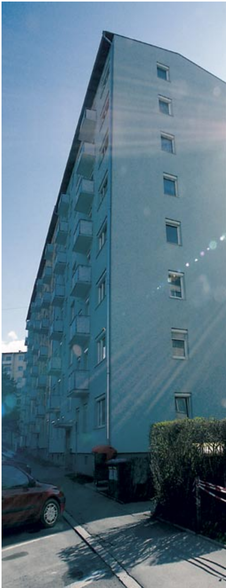
Der Brandschutz für Hochhäuser wird in Graz besonders streng ausgelegt.
