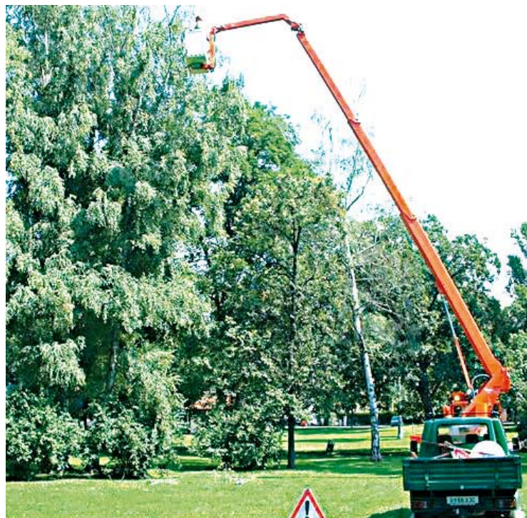
Wirtschaftsbetriebe: Gute Arbeit bei Baumschutz und Baumpflege
