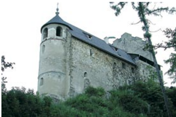
RUINE GÖSTING. Hoch über Graz liegen die Reste der stolzen Burg, die zuletzt als Pulverlager der Stadt erhalten musste, bis ein Blitzschlag samt Explosion die Anlage zur Ruine machte. Berühmt ist der Jungfernsprung. Die Burgtaverne ist Di bis So von 10 bis 18 Uhr geöffnet.
